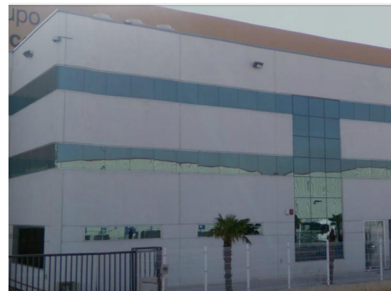
Almacenes y Oficinas Cabanillas del Campo
